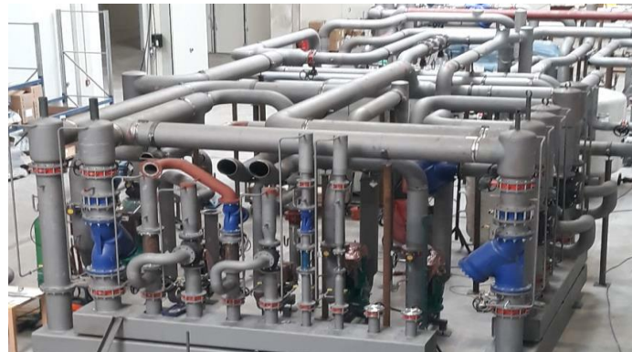
Fertigung von Rohrleitungssystemen
